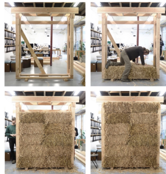
Figure 2 - Prototype réalisé au cours d'une journée de workshop par les architectes et l'artisan en vue de l'optimisation du système constructif, 2020. Crédits : Karbon.
